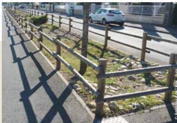
Création d'une noue au milieu de la chaussée à Riorges.
