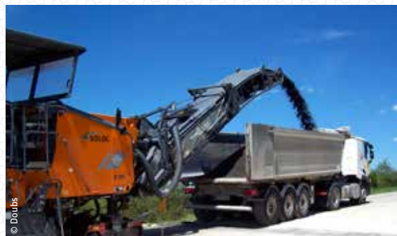
Chaque année, un million de kilomètres de routes est rénové ou créé en France.
