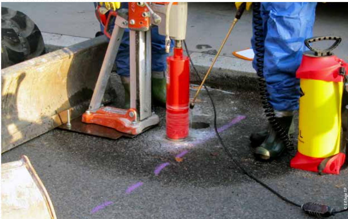
Un ouvrier effectue un carottage en vue de mesurer les HAP présents dans l'enrobé.
