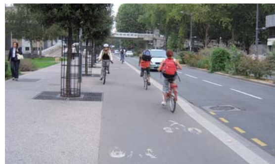
Piste contiguë à la chaussée
