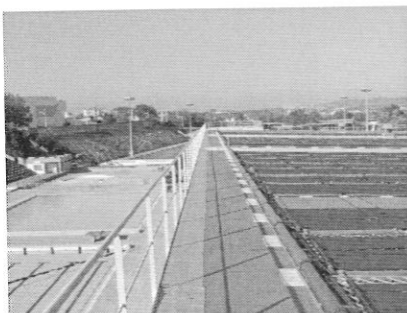
Photo 2 : Moquette solaire de la piscine de Villeurbanne
